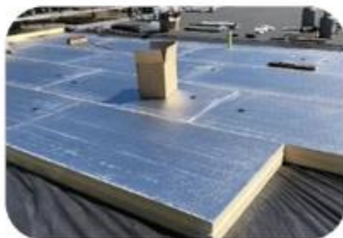
Plat dakisolatie buitenzijde
