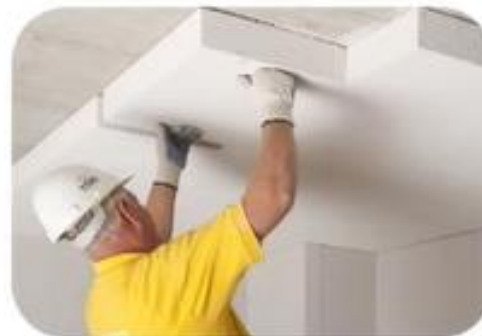
Plat dakisolatie binnenzijde
