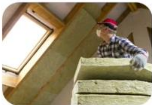
Schuin dakisolatie binnenzijde
